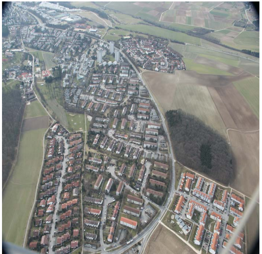
Luftbild aus nord-östlicher Richtung
