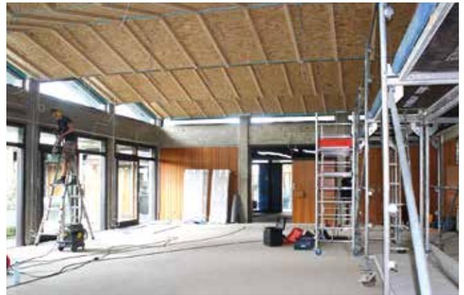
Der Saal bekommt neue Fenster und die Decke eine Wärmedämmung.
