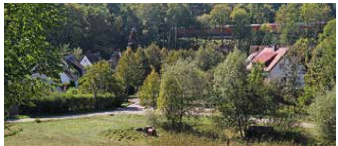
13 Wohnhäuser schmiegen sich unterhalb der Bahnlinie ins Örling er Tal.
