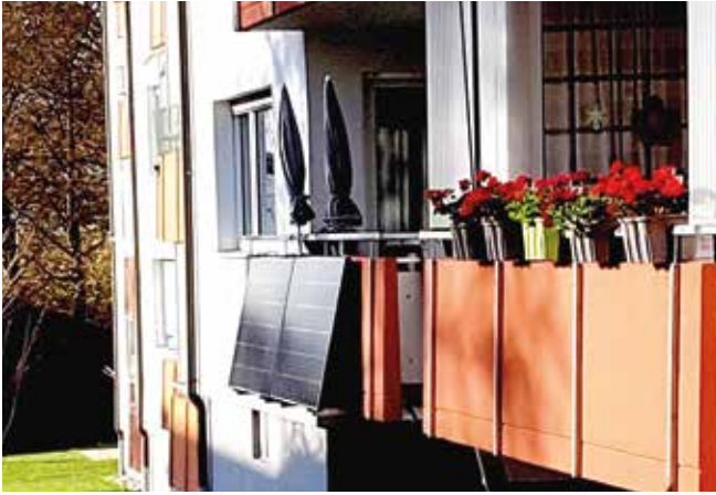
Auch in Etagenwohnungen ist oft eine passende Fläche für eine PV-Anlage vorhanden. Foto: Wilfried Clauß
